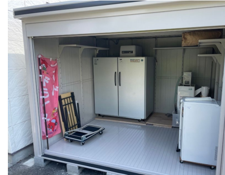
要望のあった保管倉庫を設置
